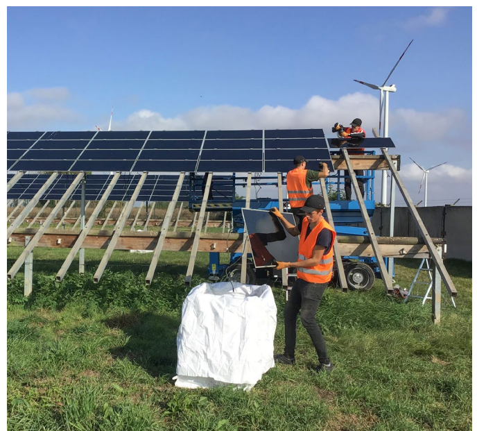
Demontage von PV-Modulen. Quelle: CEE Group
