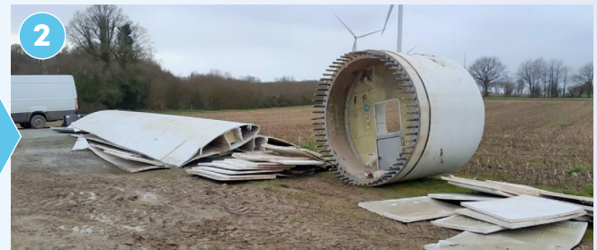
2 Zersägen in kleine Teile für besseren Transport. Arbeit in geschlossenem Zelt, zur Vermeidung von Umweltbelastung durch Staub.
