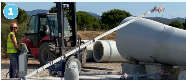
1 Zersägen der Blätter in Abschnitte mit Diamantsägeblatt. Bewässerung zur Staubvermeidung und zum Auffangen der Sägereste
