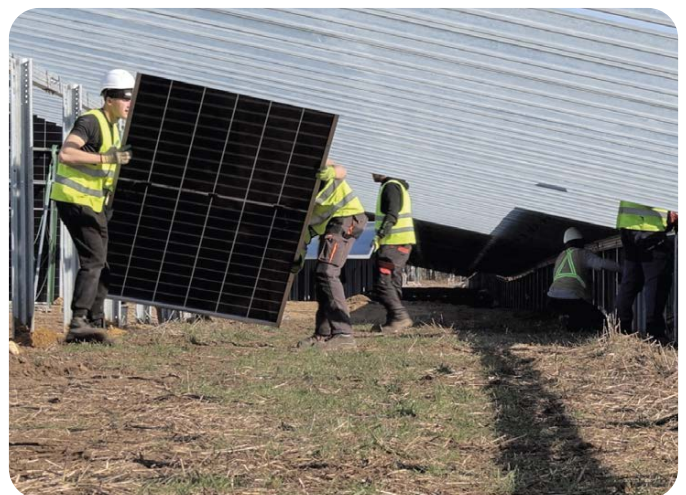
Demontage von PV-Modulen. Quelle: CEE Group
